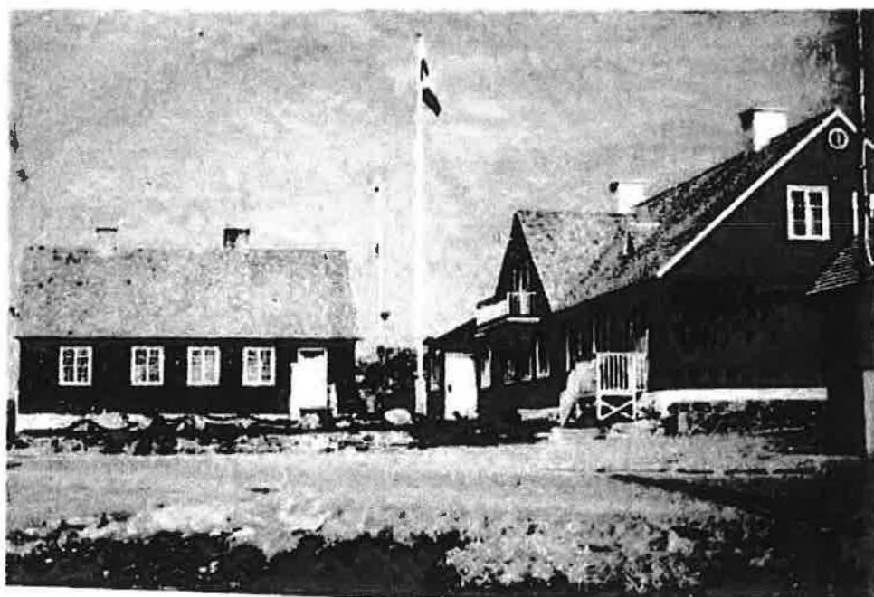
B-24 og assistentboligen B-43. B-43 er et brædeklædt bindingsværkshus fra i 1905.
