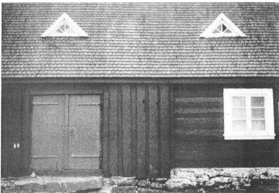
Bestyrerboligen er opført i stokværk. Tilbygningerne i enderne er i bindingsværk beklædt med brædder.
