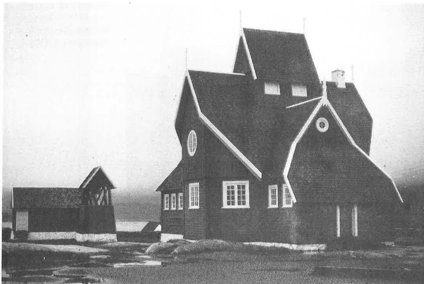
Kirken B-67 kaldes i daglig tale "Vorherres Blækhush" med henvisning til bygningens særprægede udseende. Den er tegnet af arkitekt Helge Bojsen Møller i 1913 og i det ydre udformet over rumgeometriske principper.
